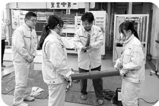
水道配水用ポリエチレン管の切断
