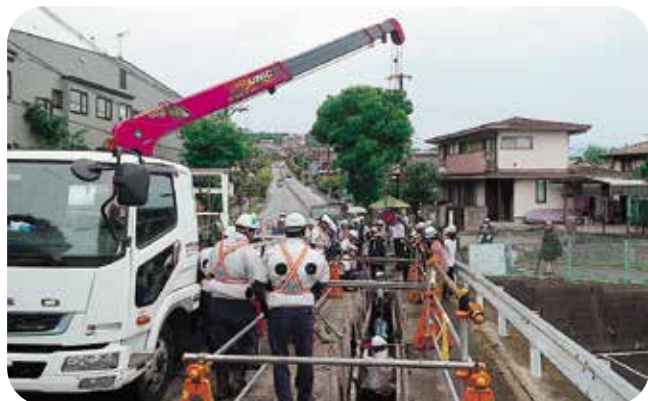
管の吊り下げと布設
