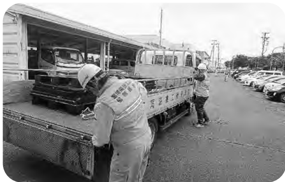
仮設水槽の積み込み（於：卸町庁舎）
