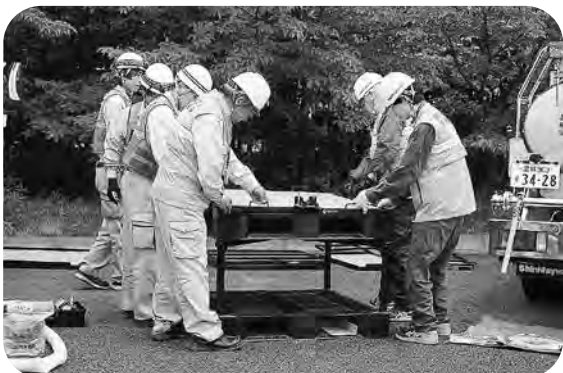
仮設水槽の組立て（於：消防学校）
