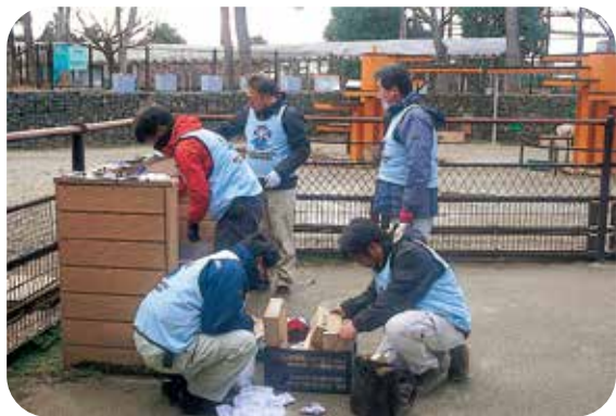
手洗い場のパッキン交換
