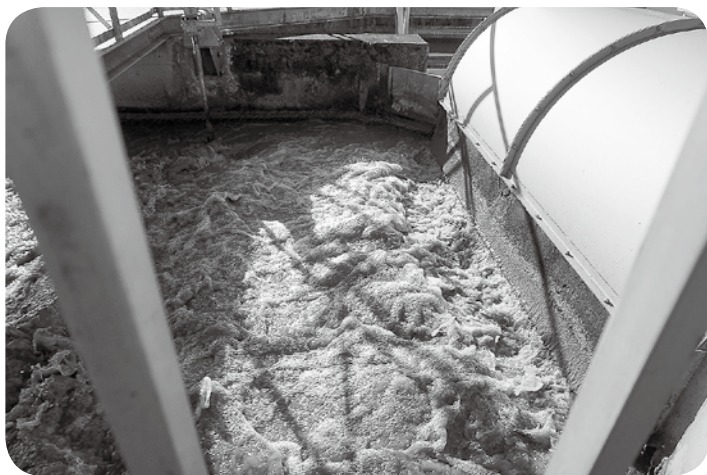
ローター：攪拌で空気を入れ水流を作る
