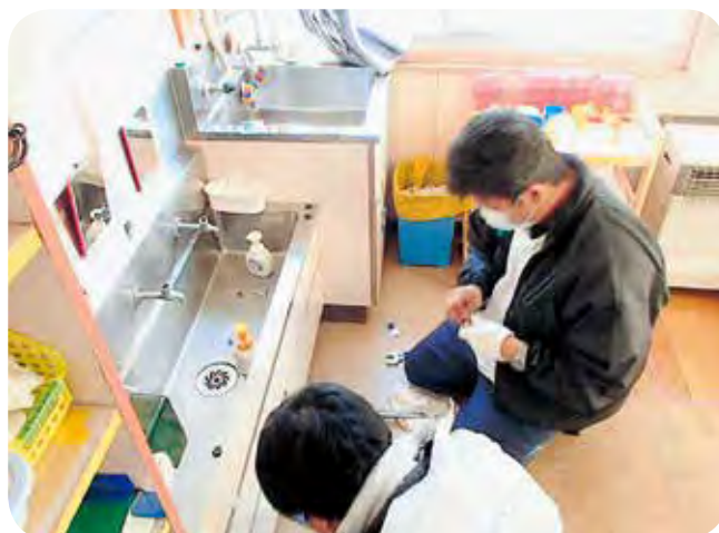
鶴ヶ谷保育所での作業の様子
