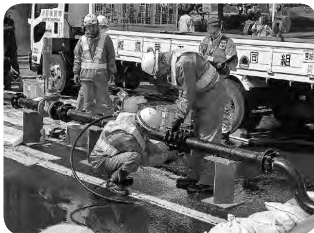
第3回国連防災世界会議の際に行われた配水管応急復旧デモンストレーションの様子（平成27年3月、仙台で開催）
