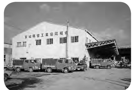
扇町事業所 (昭和45年10月竣工)
