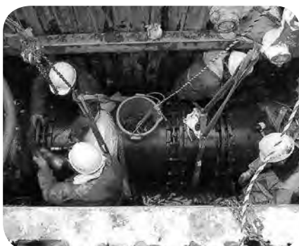
東日本大震災における配水管 復旧作業(平成23年3月)
