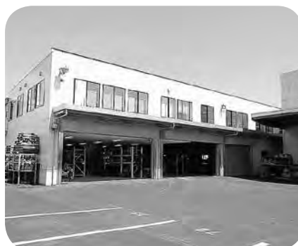
扇町事業所整備工事完了・北 倉庫完成(平成24年3月)
