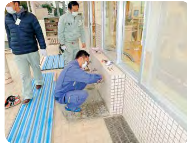
水道の点検（南小泉保育所）
